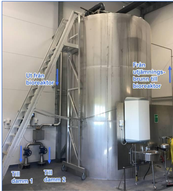
Ursprunglig bioreningsprocess för processavloppsvatten
